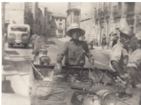
Arreglant la carretera, anys 60
