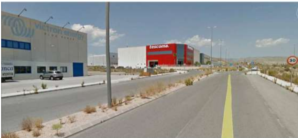
Vialidad ejecutada, encintada y asfaltada. En uso. Fuente: Google Earth.
