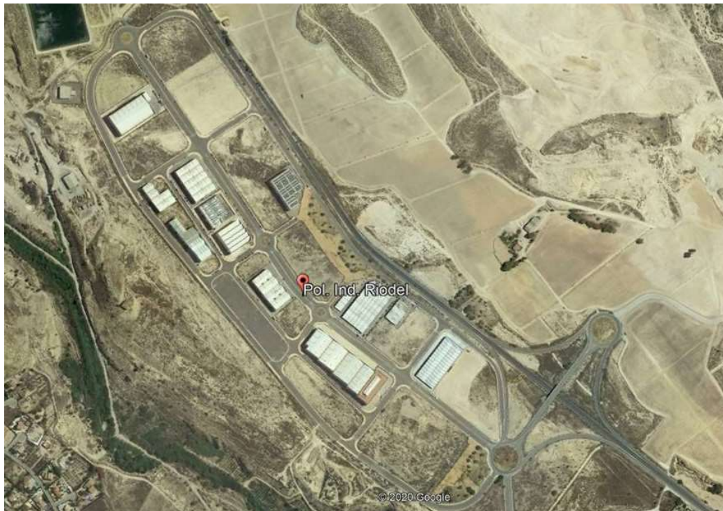
Vista aérea del polígono industrial Riodel. Fuente: Google Earth.
